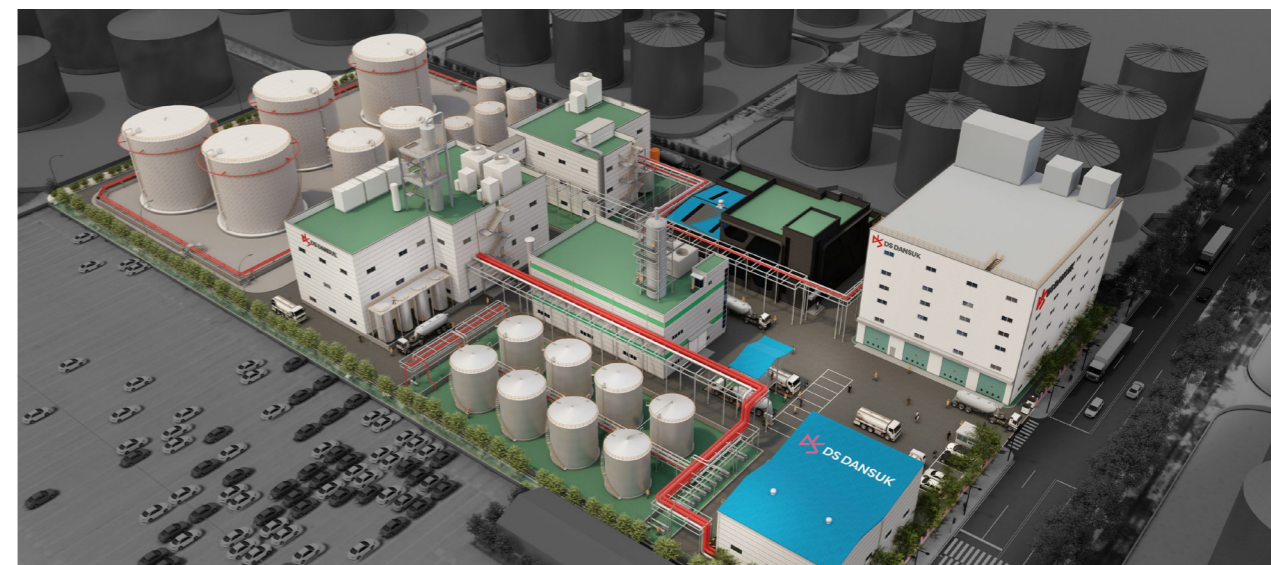
DS丹石生物平泽第1工厂HVO-Pre Treatment Unit 鸟瞰图
