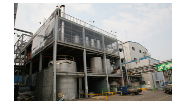
生物柴油生产工厂竣工
