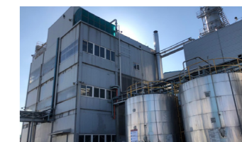
生物重油生产工厂竣工
